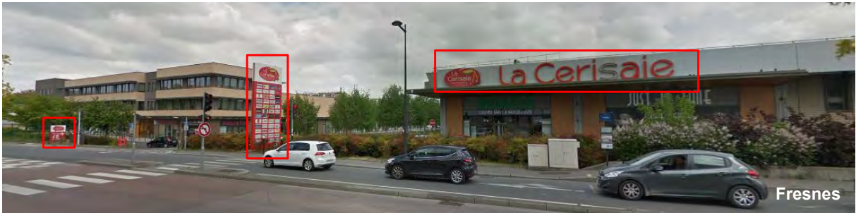
Zone commerciale de la Cerisaie, bonne intégration des dispositifs – totems et enseignes en façade – Source : Even Conseil, 2019
