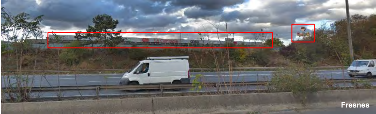
Effet vitrine recherché avec des enseignes qualitatives implantées en bandeau ; un totem grande hauteur qui traduit la recherche de visibilité depuis l'A6 – Source : Google Streetview
