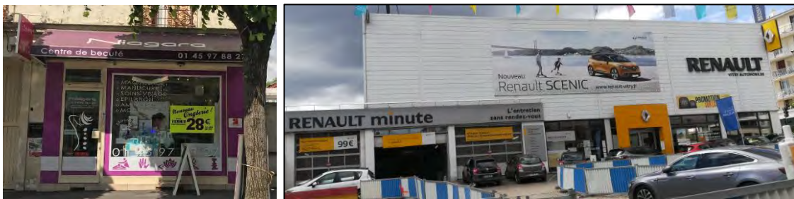
Exemples d'enseignes en façade – Source : Even Conseil 2019
